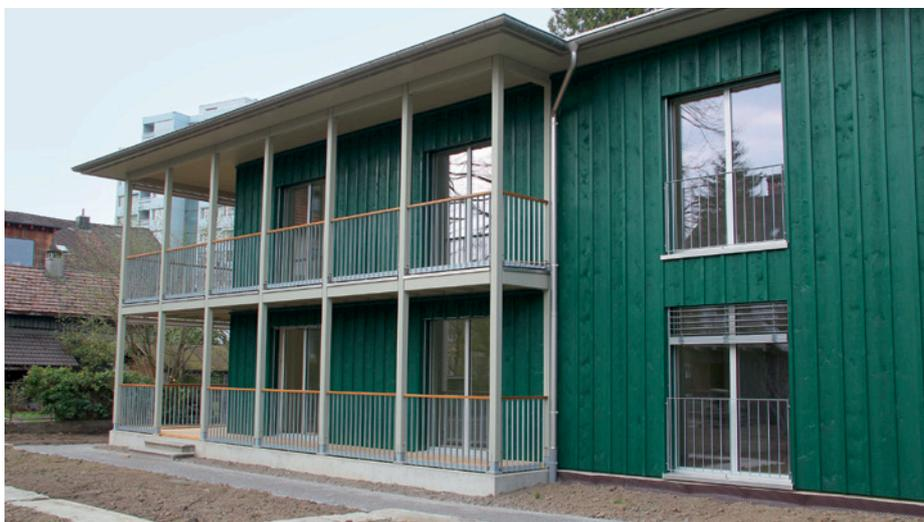
Diese Holzfassade eines Mehrfamilienhauses in Aarau wurde mit einer wässrigen Ölfarbe beschichtet. Ausführung: Mazzei Malerarbeiten, Gränichen.
