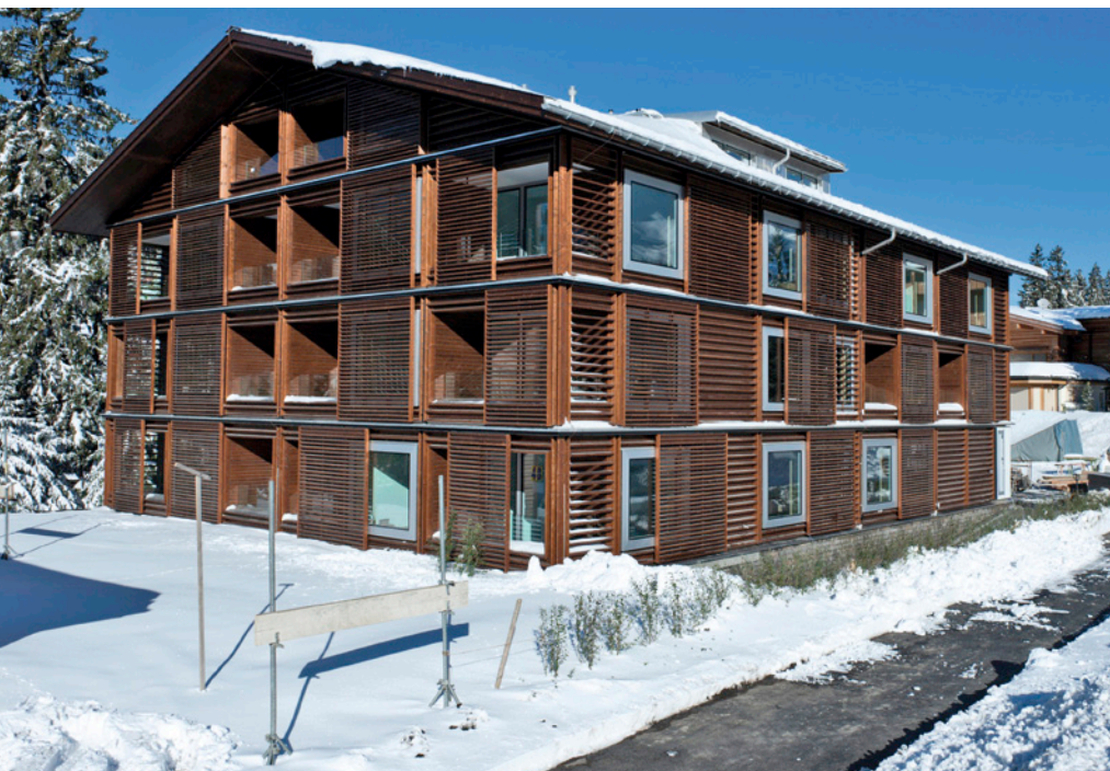
Dieser Holzbau in Valbella wurde mit der wässrigen offenporigen Öllasur Arbezol Aqualin von Bosshard behandelt. (Bild: Bosshard)
