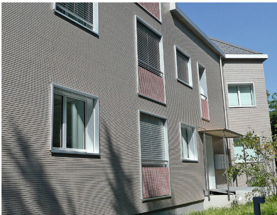
Der Schindelschirm dieses Mehrfamilienhauses in Bern wurde vom Malergeschäft Kneubühler AG mit der wasserverdünnbaren Öl-Holzlasur Biofa beschichtet. (Bild: Thymos)
