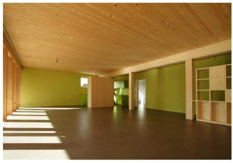
Mit dem Biofa Steinöl Aqua wurde in Schöftland im Kanton Aargau ein modernes und in konsequent ökologischer Bauweise ausgeführtes Mehrfamilienhaus behandelt. Auf die Anhydritböden wurden drei leicht eingefärbte Schichten Biofa Steinöl Aqua aufgebracht. Auch die Treppen und Verkehrsflächen wurden bei diesem Pilotprojekt so behandelt.
