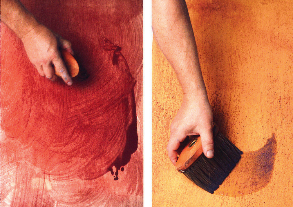
Aufbringen von pigmentierter Kalklasur (Bild aus «Kalkfarben, Kalkspachtel»).
