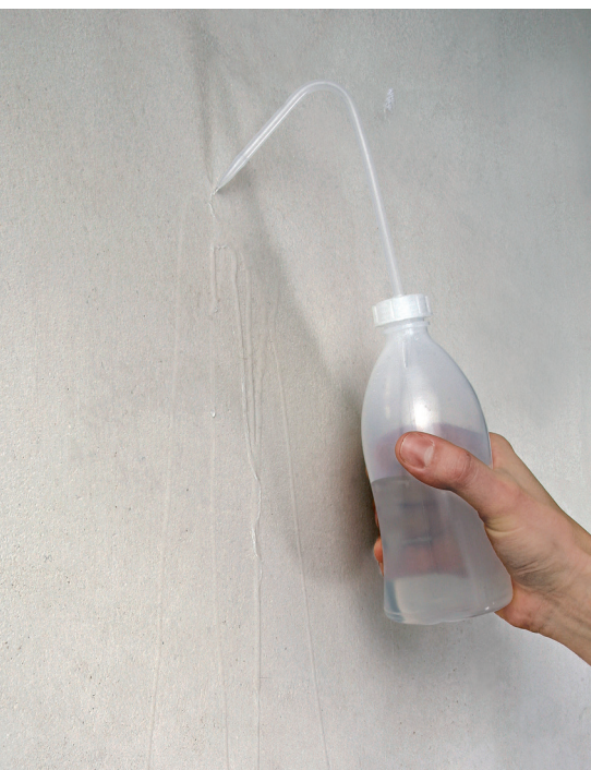
Hier wird die Saugfähigkeit des Untergrunds geprüft.
