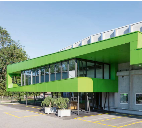
Für Rockpanelplatten muss ein passendes Beschichtungssystem ermittelt werden. (Bild: Sperrag Jago / Rockpanel)
