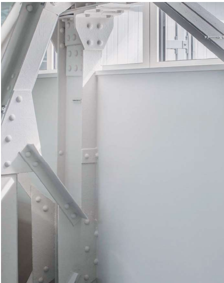
Eine Vorsatzschale aus Trockenbauplatten sorgt für guten Schallschutz zu einer angrenzenden Industriehalle. Die Anpassungen an das filigrane Stahlfachwerk verlangte Massarbeit. (Bild: T+A/Fabian Linden)
