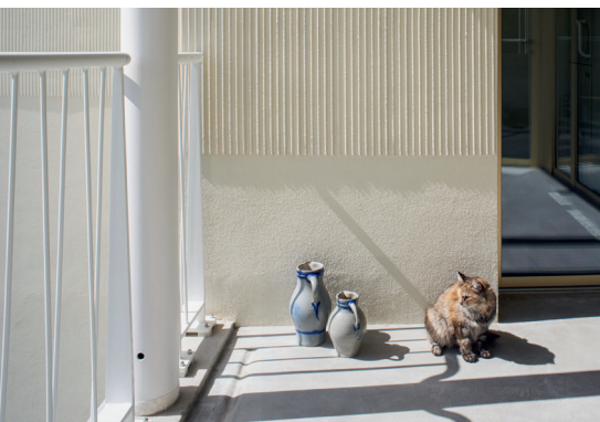
Ein gerillter Kammzugputz zeigt die oberste Fassadenpartie an.
