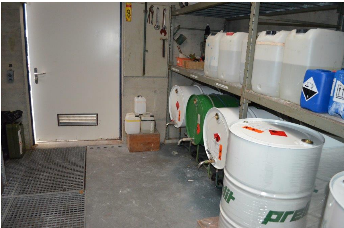
✓: Lösungsmittellager mit Auffangbecken
