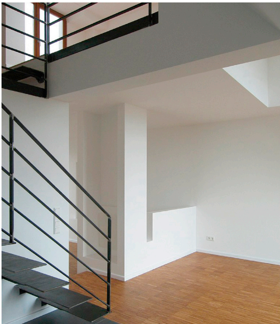
Unregelmässigkeiten in Beschichtungen durch seitlichen Sonnenlichteinfall sind in der Regel hinzunehmen. (Bild: Schromann)
