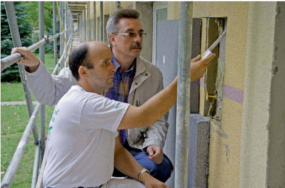
Prüfung des Untergrundes mit Probeöffnung des alten Wärmedämm-Verbundsystems. (Bild: Sto)
