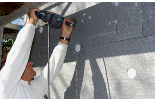
Anschrauben der Aufdoppelung mit Dämmplattendübeln. Die Dübel werden versenkt und anschliessend zum Beispiel mit StoThermo-Rondellen abgedeckt. Dies bewirkt eine Minimierung der Dübelabzeichnung. (Bild: Sto)
