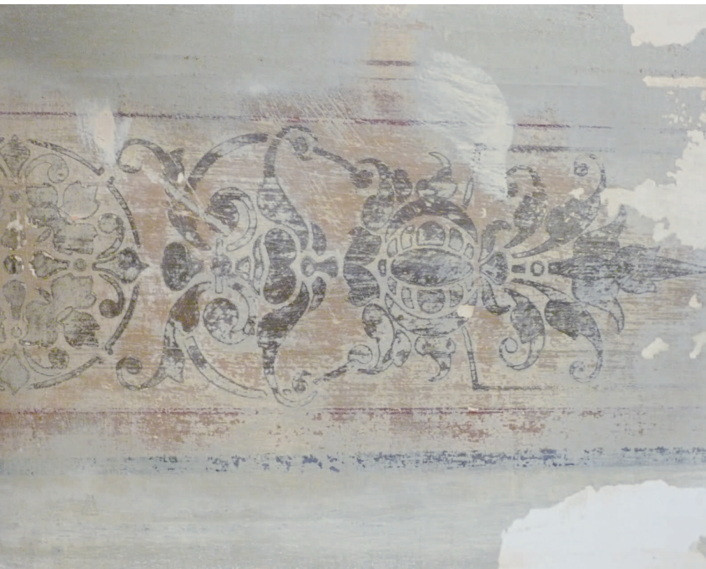
Eine erfreuliche Überraschung: Deckenornament in einem Stadtberner Haus aus der Zeit der Wende vom 19. zum 20. Jahrhundert nach der Freilegung. (Bilder: LoryBau)
