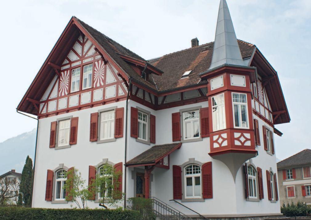
1906 erbautes Wohnhaus mit Arztpraxis in Sarnen. Die Walter Zünd AG strich die Fassade sowohl beim Neubau als auch bei den Renovationen 1928, 1956 und 2001.
