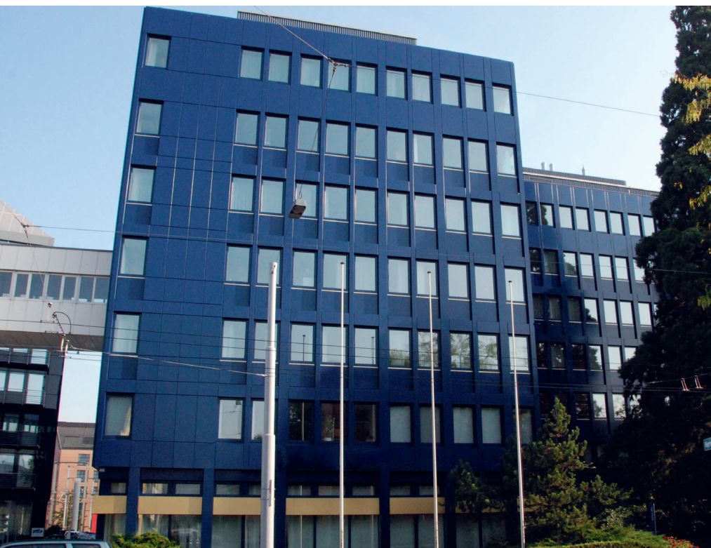
Das Gebäude der Bank Julius Bär in Zürich-Altstetten vor und nach der Renovation.
