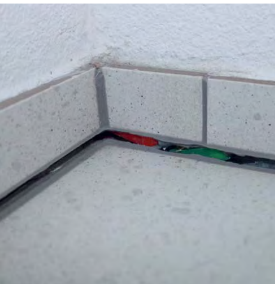
Abb. 12: Aufgerissene Fuge.
