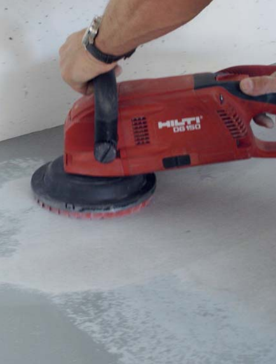
Untergrundvorbereitung mit Tellerschleifer.
