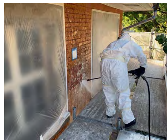
Der Abbeizer wird mit dem Heisswasser-Hochdruckreiniger abgewaschen.
