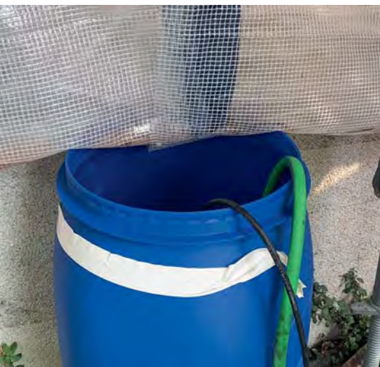
Eine Auffangrinne aus Gerüstplanen leitet das Abwasser in Kunststofffässer.
