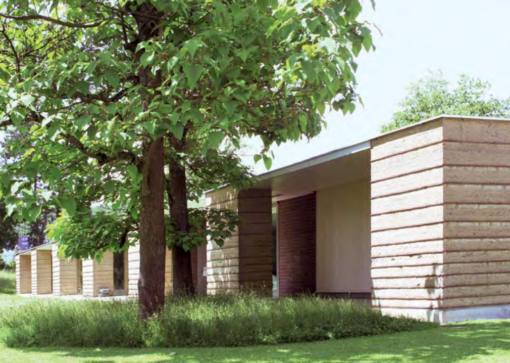
Boltshauser Architekten bauten ein Schulgebäude von 1958 mit viel Lehm zum Hort um. (Bild: Achim Pilz)
