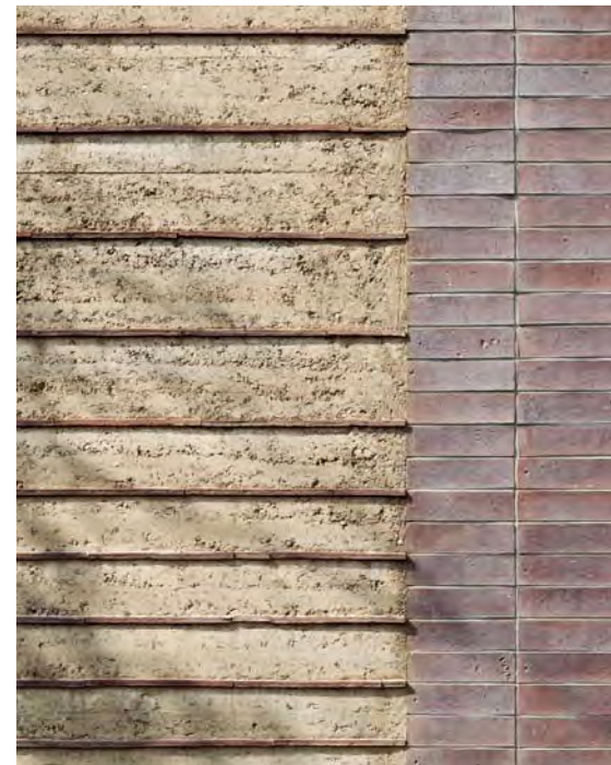
Nahaufnahme einer Stampflehwand. (Bild: Boltshauser Architekten)
