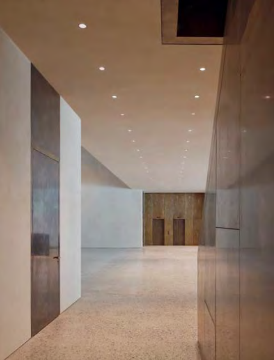
Die Gipser putzten 1200 Leuchten ein. (Bild: Hanspeter Schiess für Cukrowicz Nachbaur Architekten)
