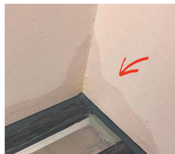
Fugenlose Wandbeschichtung mit optischem Mangel wegen Feuchtigkeits-hinterwanderung.
