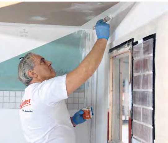
Ob im Neubau oder im Bestand: SiliPainter Pro macht die Silikonfuge überstreichbar. (Bild: SiliPainter/B&T)
