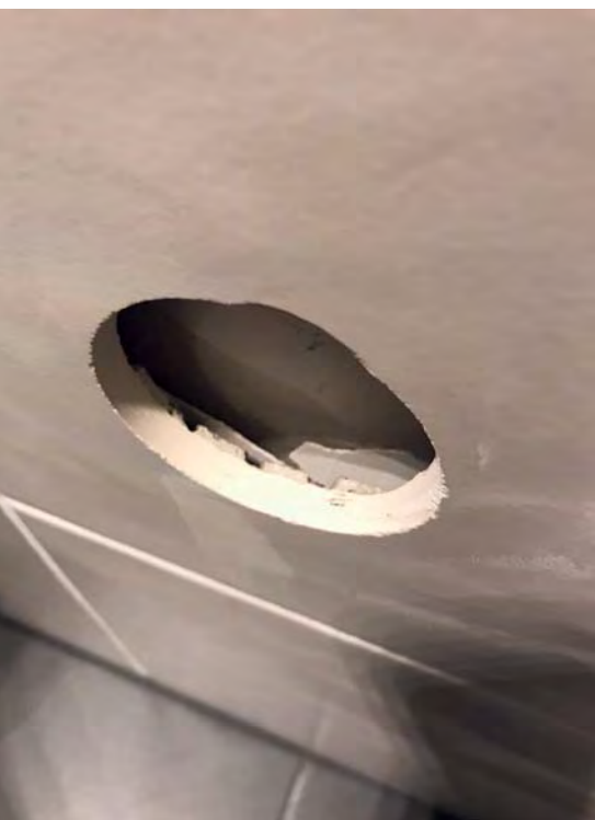
Hohlstellung des Fliesenbelags infolge Schwindung der Betonwand.
