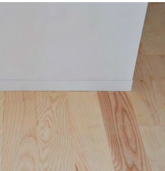
In die Wand eingelassene Sockelleiste. (Bild: Raphael Briner)
