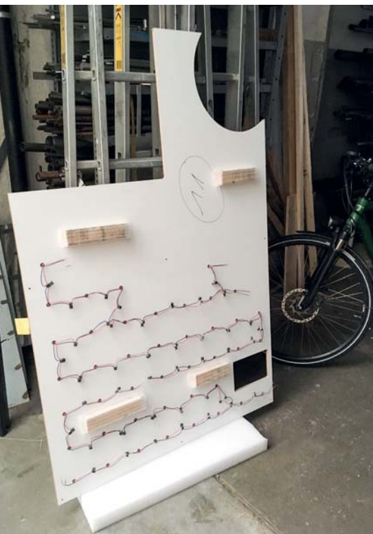
Ein Schreiner schnitt die Deckenplatten samt Lochungen mit einer CNC-Maschine zu. Noch vor der Montage bekamen sie die Verdrahtung für die Leuchten. (Bilder: Goepfert & Friedel AG)
