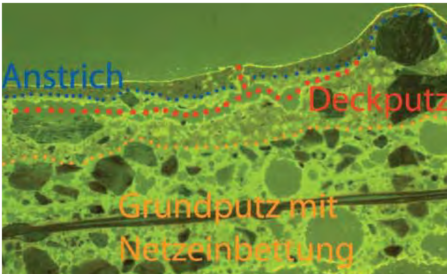
Fluoreszenzaufnahme eines Putzaufbaus mit Riss (rote Punkte) im Querschnitt.
