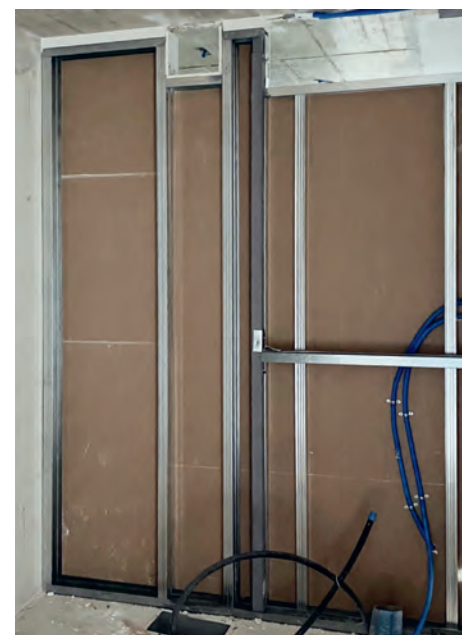
Die Nachrüstung einer Wohnungstrennwand mit geeigneter Unterkonstruktion als Lastaufnahme für Sanitärinstallationen.
