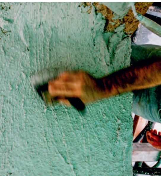
Einschlämmen des Rania-Mörtels in die Rauwacke-Oberfläche als Kontaktschicht.
