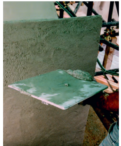
Händischer Auftrag des Glattputzes.
