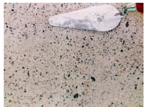
Fertige Putzstruktur mit freigelegten und gewaschenen Sandkörnern.
