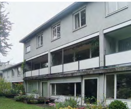
Balkonfassade des Mehrfamilienhauses Billrothstrasse 14/16 in Zürich vor und nach der Sanierung. (Bilder: oben Andreas Edelmann, unten Nina Mann)
