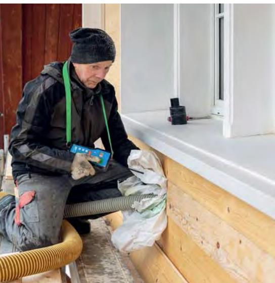
Zellulose wird hinter die Schindelfassade eines denkmalgeschützten Appenzellerhauses geblasen.
