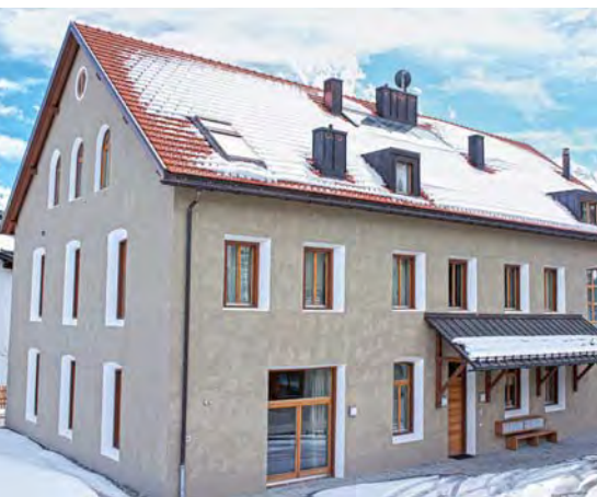
Eine Fassadensanierung mit Dämmputz bietet grosse Gestaltungsfreiheit.
