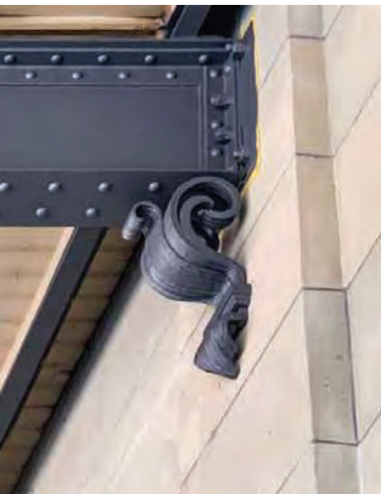
Dekoratives Element an einem Stahlträger des Seitendachs.
