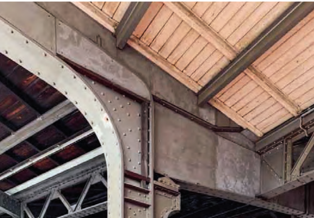
Der Zustand der Perronhalle vor Beginn der Arbeiten. (Bilder auf dieser Doppelseite: Hans Gassler AG)
