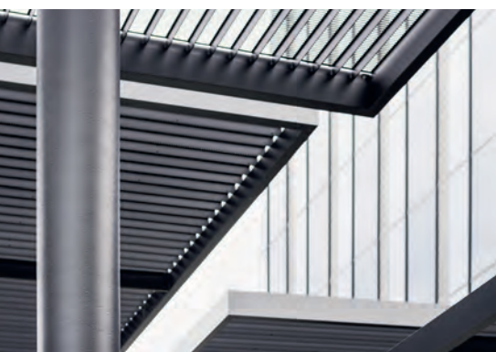
Pulverbeschichtetes Vordach mit Nasslack-Umrandung. (Bilder auf dieser Doppelseite: Dold AG)
