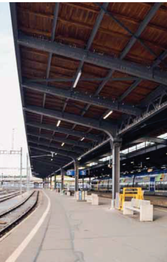
Weil das äusserste Gleis täglich befahrbar sein musste, konnte es nicht komplett saniert, sondern musste teilsaniert werden. (Bilder auf dieser Doppelseite: Raphael Briner)
