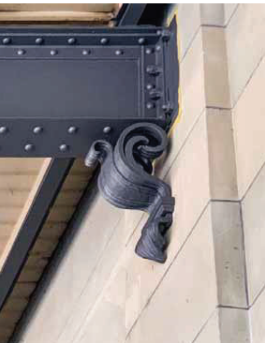
Dekoratives Element an einem Stahlträger des Seitendachs.
