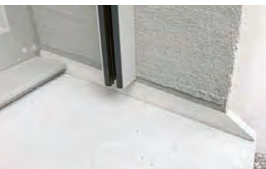
Putzbordanschluss mit sichtbarem Fugendichtungs- band.
