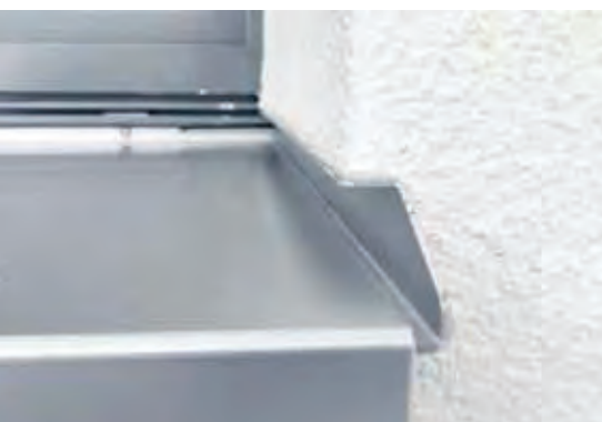
Entkoppeltes Putzbord mit Dehn- und Stauchzone.
