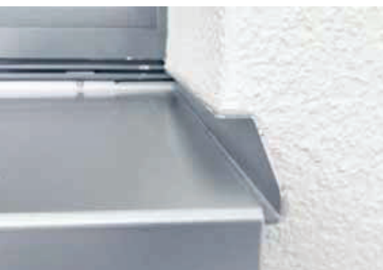
Entkoppeltes Putzbord mit Dehn- und Stauchzone.
