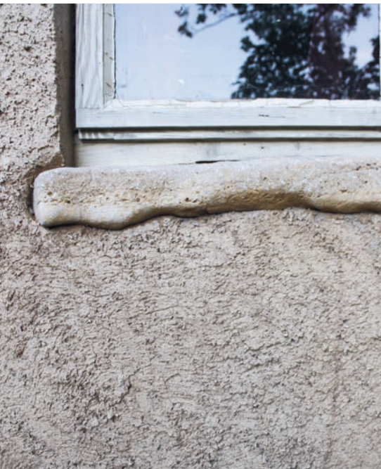
Ein grosser Kalkstein bildet die Fensterbank.
