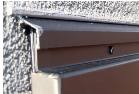
Vorstehende Fensterkästen. (Bilder: Michael Hladik)
