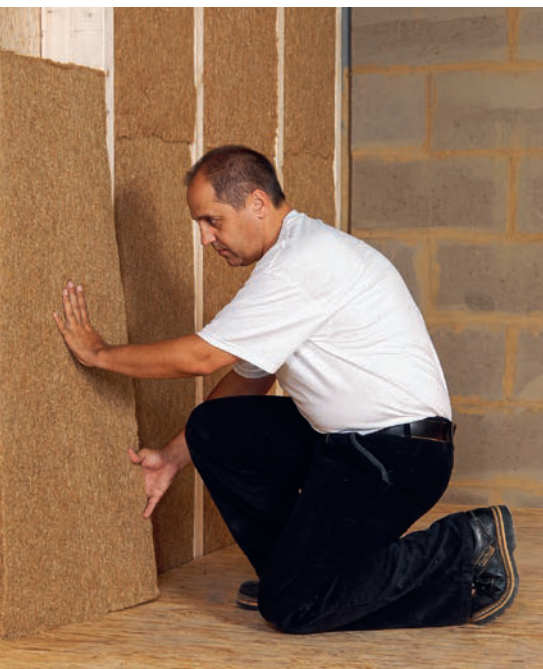
Montage einer Dämmstoffplatte aus Hanffasern. (Bild: Stroba Naturbaustoffe)
