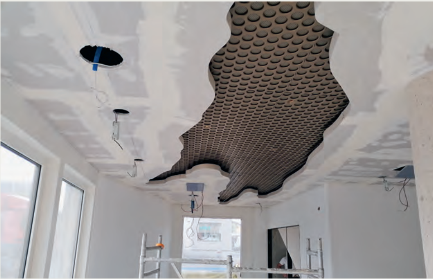
Deckenansicht im Rohbau.
