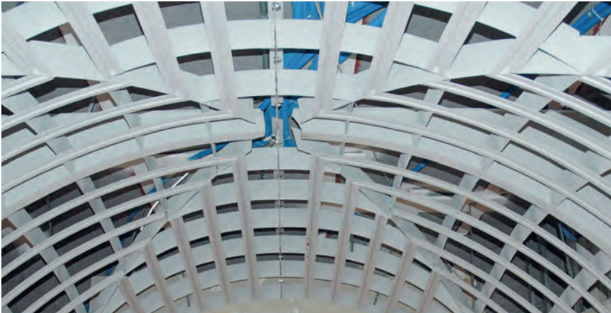
Bei der Restaurierung des Landesmuseums Zürich liess sich das Gewicht der Konstruktion um etwa 65 Prozent reduzieren.
