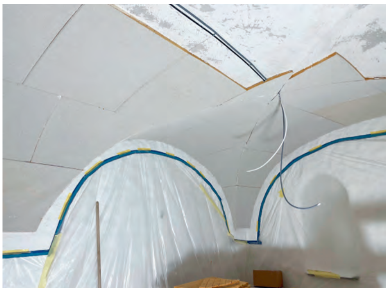
Die Platten werden an der Decke verklebt.
