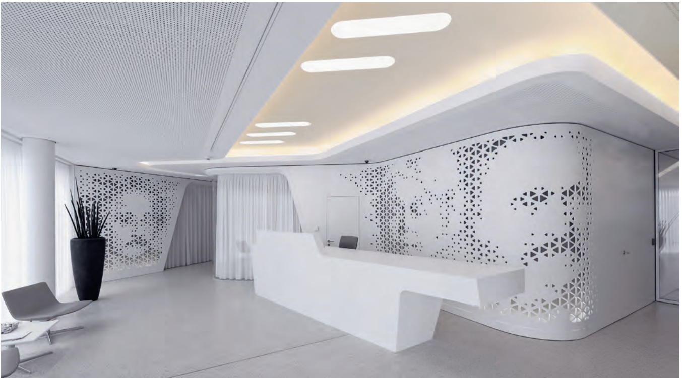
Wände aus Hi-Macs-Panelen werden in der Raiffeisen- bank in Zürich zu reinen Kunstwerken Bild: Jan Bitter
