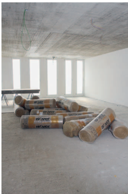
Es gibt viele Arten von Wärmedämmungen. Wichtig ist jedoch, dass sie tatsächlich eingesetzt werden. Bild: Cornelia Sigrist
