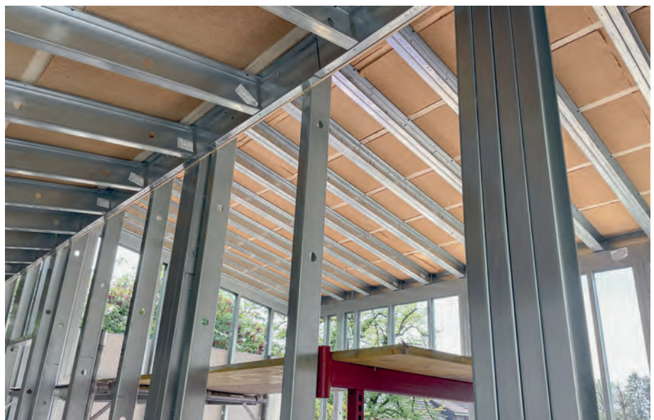
Die Wand- und Dachkonstruktionen sind komplett in leichter Stahlleichtbauweise ausgeführt.
