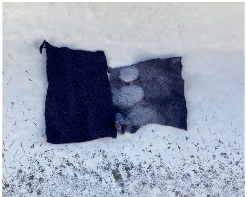
Mit einem dunklen Baumwollstoff wurde die Beschichtungsfläche trocken abgerieben. Links ist ein unbenutztes Stück Stoff zu sehen, rechts das Stück, das für den Test verwendet wurde. Es zeigt sich die starke Auskreidung. Bilder: IABP
