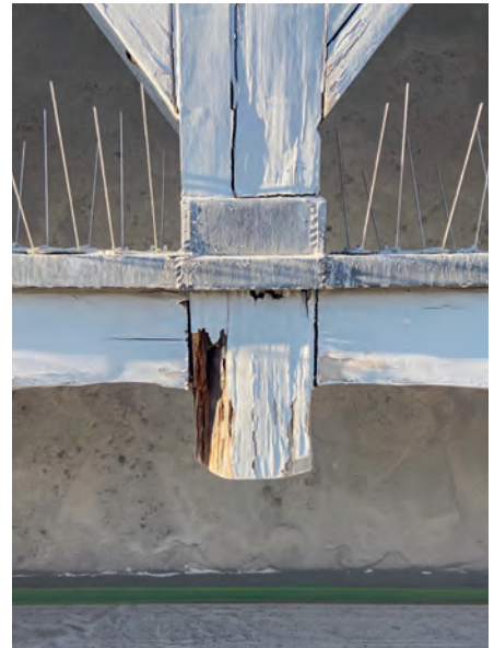
Die Holzelemente unter dem Dach zeigten ebenfalls Altersschwächen. Bild: zVg
