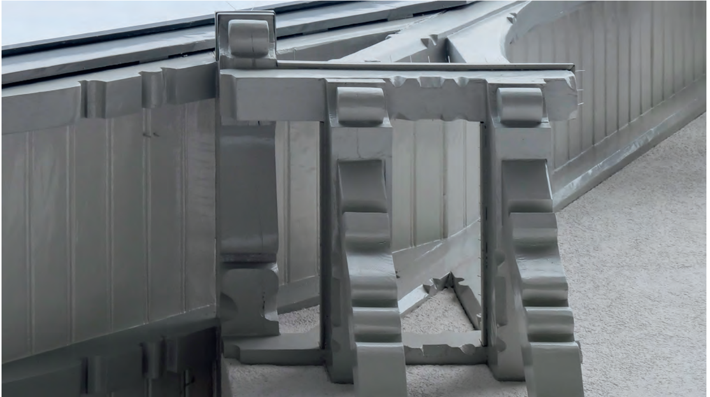
Die Holzanstriche bestehen alle aus nachwachsenden Rohstoffen, Leinöl und Pigmentpulver.
