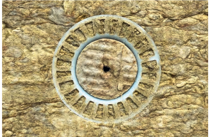
Genügend Dübel sorgen für Standsicherheit der VAWD. Bild: zVg
