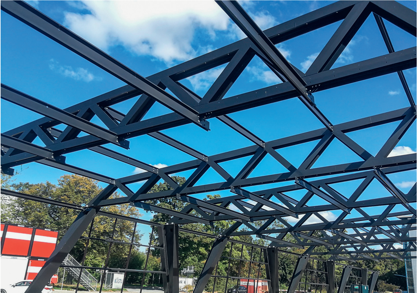
Aufbau der werkseitig beschichteten 15 000m 2 Stahloberfläche.
