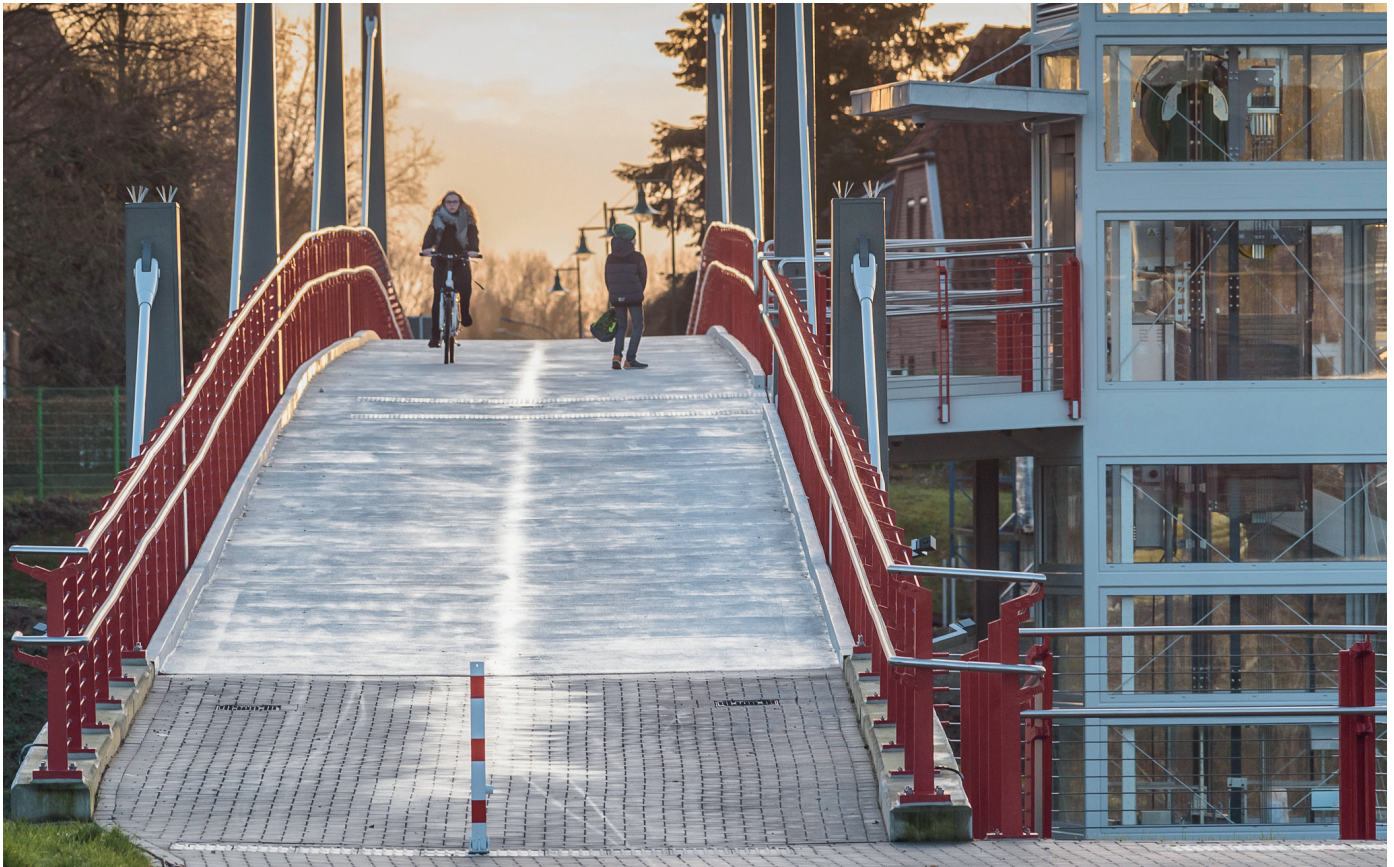
Beispielhafte Geh- und Radwegbrücke mit verschleissfestem Bodenbelag gemäss ZTV-ING Teil 6, Abschnitt 5 (RHD-ST).
