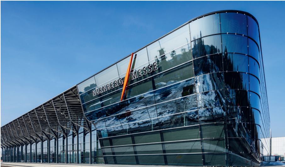
Neubau der NürnbergMesse mit 3300 Tonnen gegen Korrosion geschütztem Stahl.
