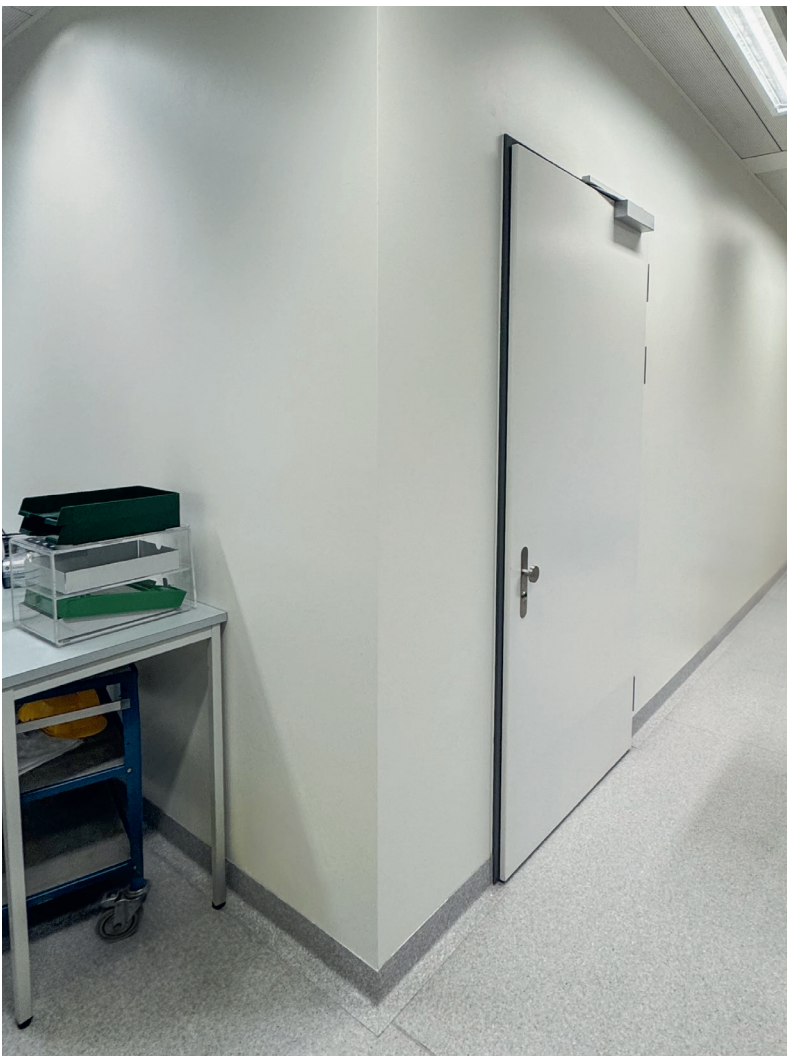
Eine Trockenbauwand trennt die Ansaugkammer vom Rest des Innenraums.
