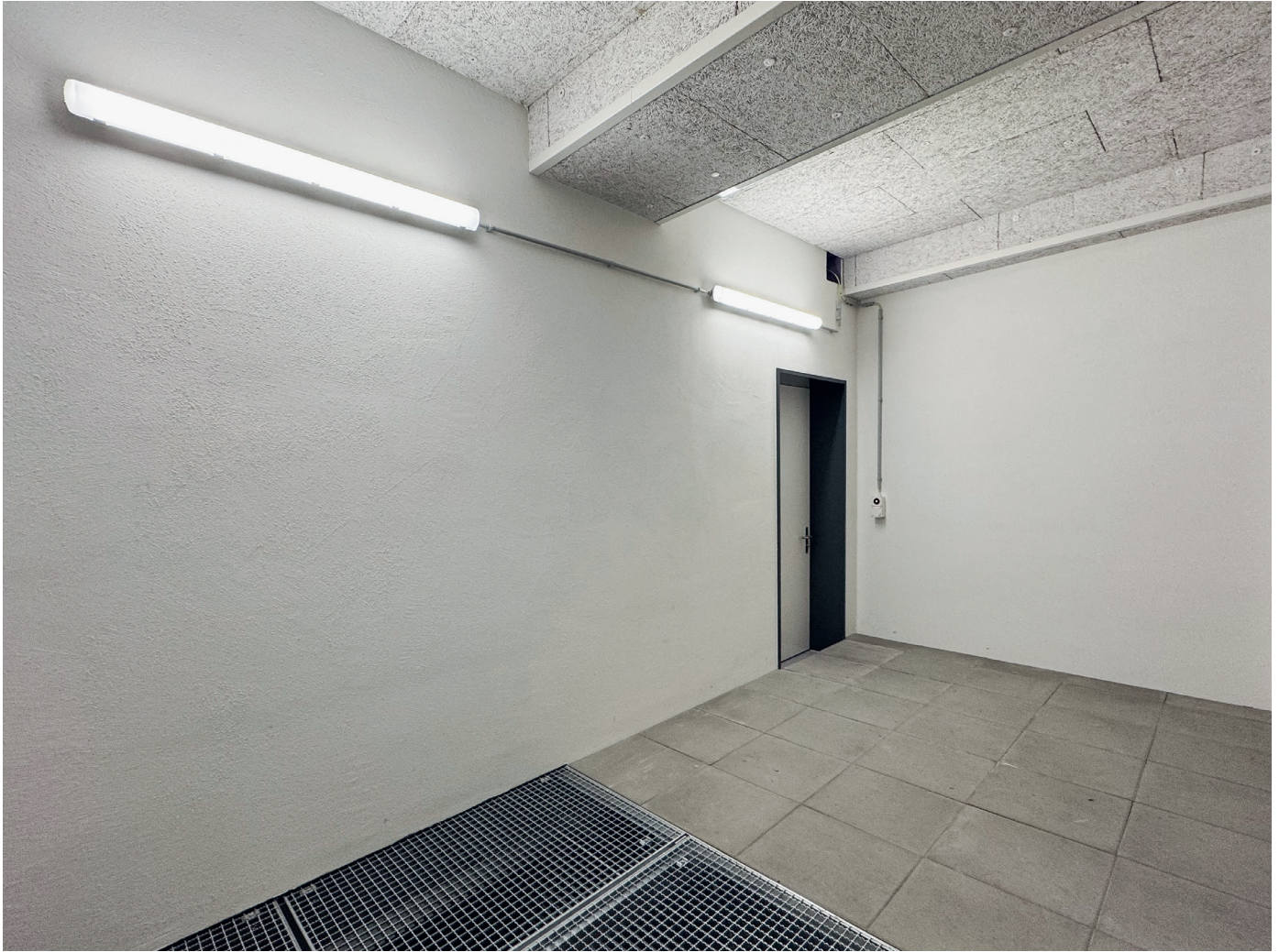
Die neu gebaute Ansaugkammer. Unten das Gitter für die Lüftung.
